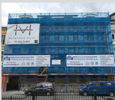
Tak- og fasadearbeider
