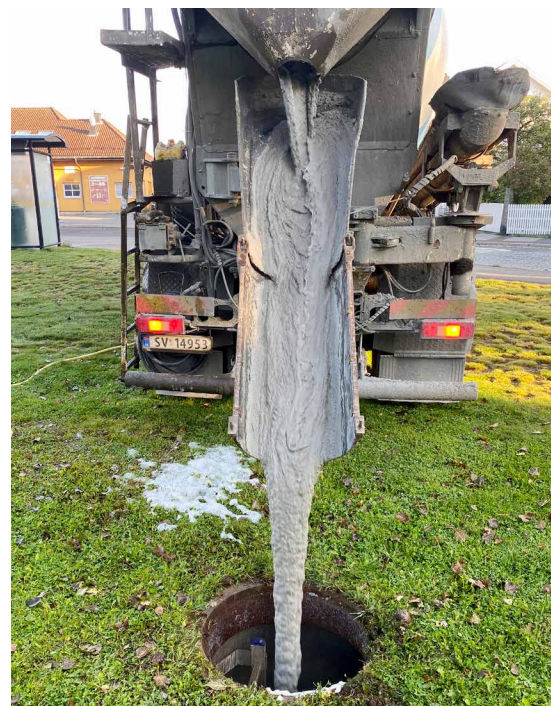
Skumbetong brukes ofte til fylling av hulrom.
