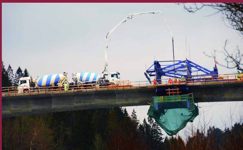
Unicon-pumier under bygging av Hallevannetbrua.
