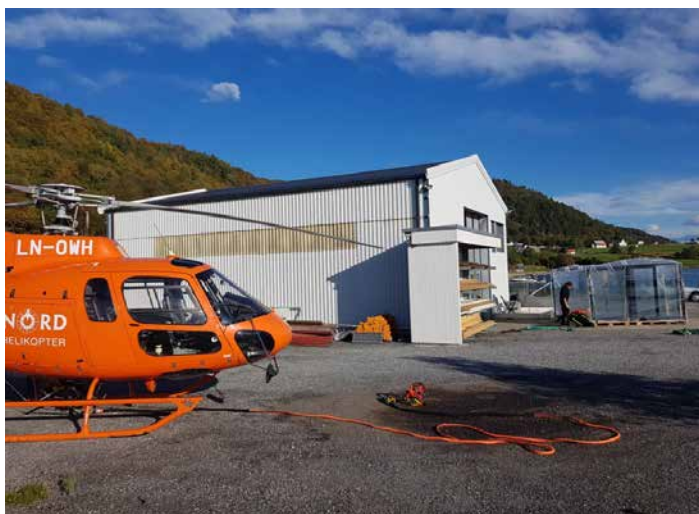
Helikoptertransport av vinduer
