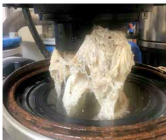
Filler og fett i avløpet tetter rørene.
