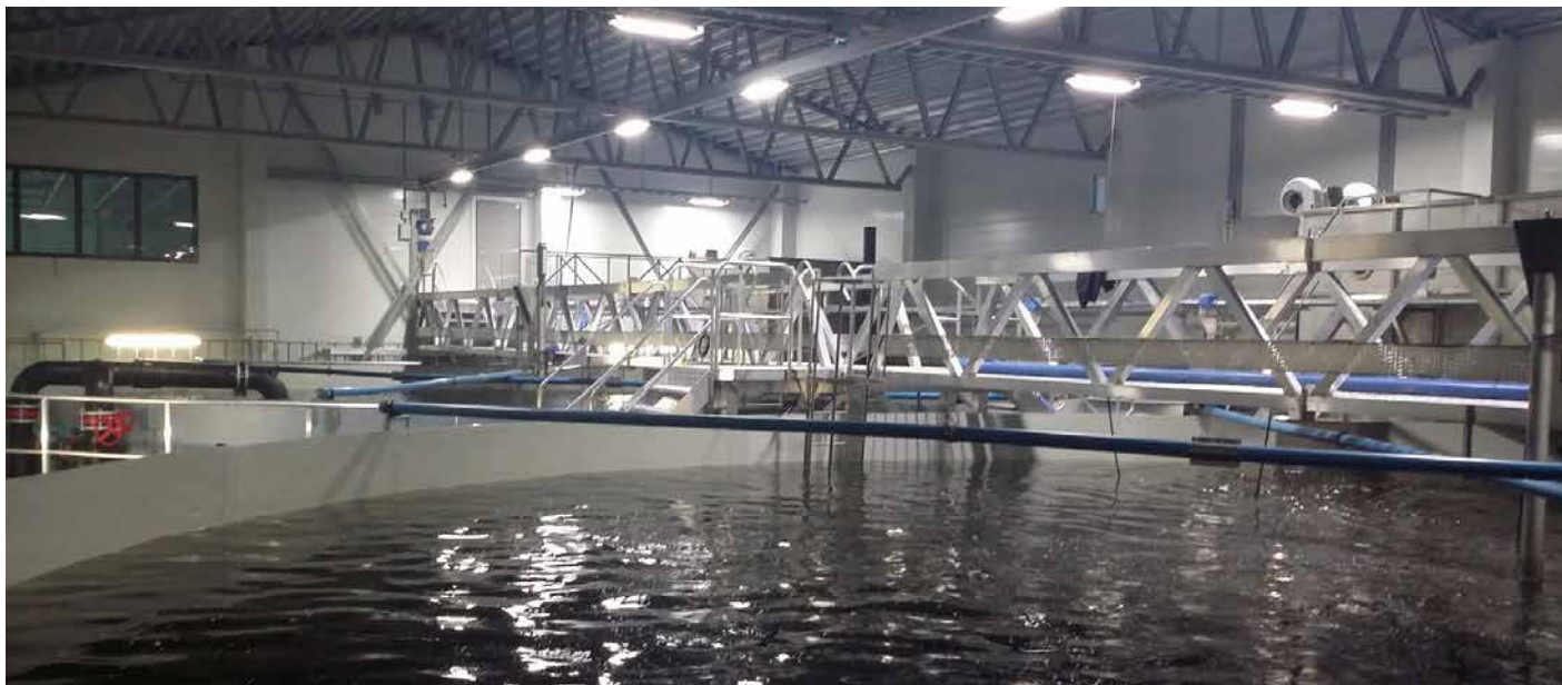
Gangbru i aluminium med fritt spenn på 16,5 meter.
