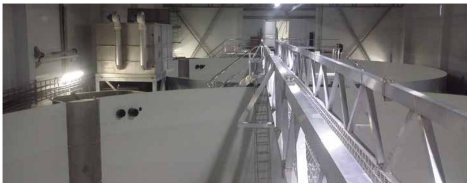
Gangbru i aluminium med fritt spenn på 16,5 meter.
